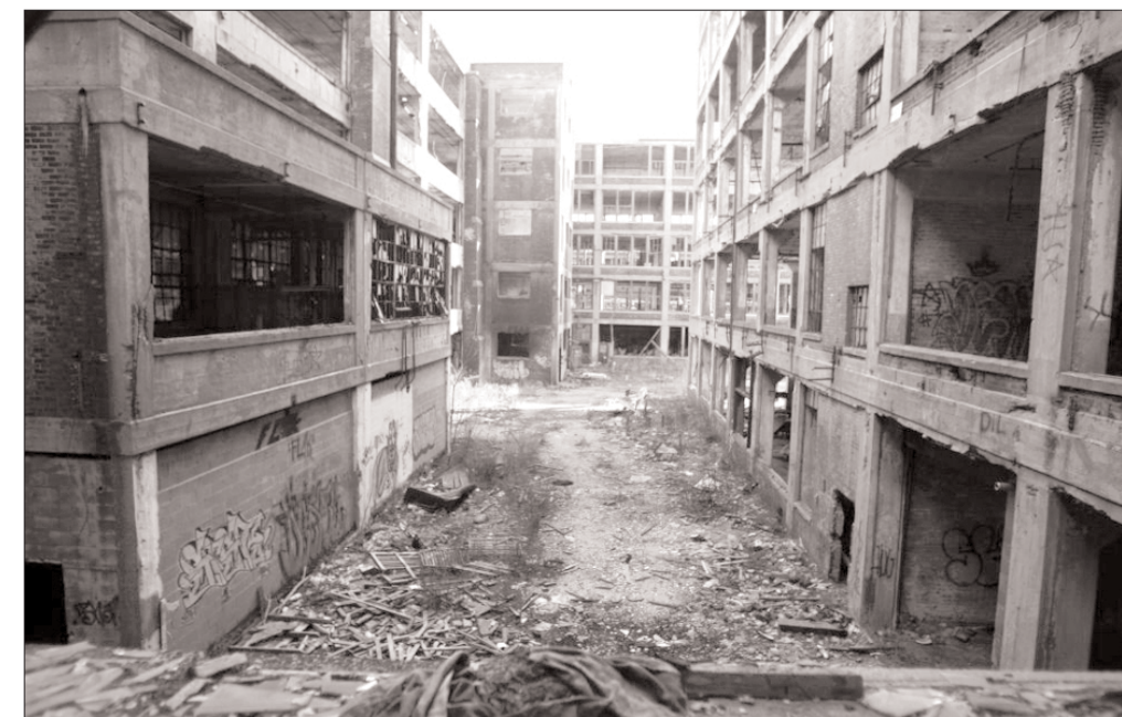
Imagen desoladora de una fábrica abandonada en Detroit, ciudad que declaró su bancarrota el pasado diciembre
